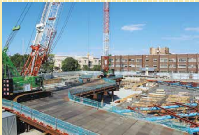
新庁舎工事現場全体
