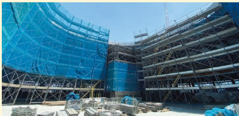
2階市民活動スペースから見た工事の様子
