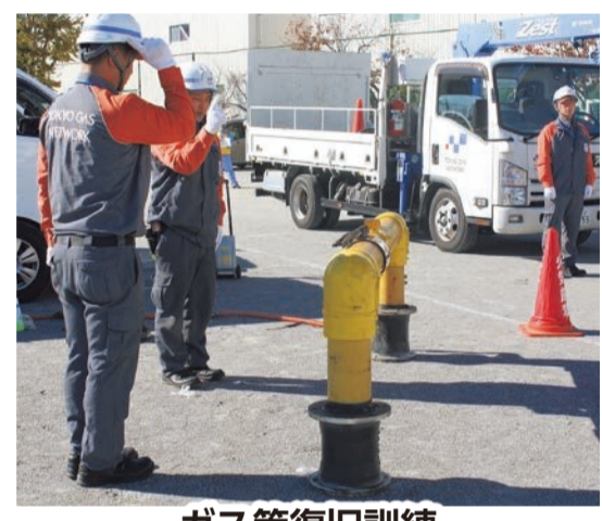
ガス管復旧訓練
