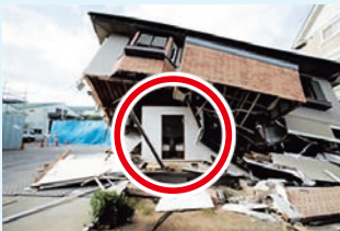
耐震シェルター
