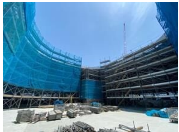
【市民活動スペースの工事の様子】
