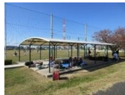
屋根付き休憩施設
