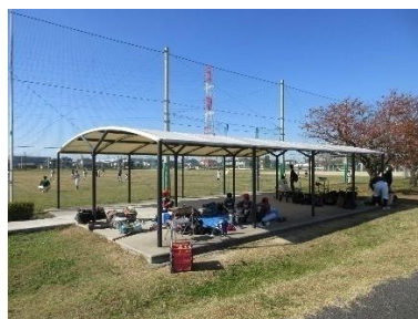
屋根付休憩施設
