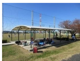
屋根付休憩施設
