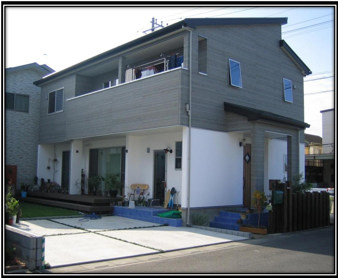
道路に面した部分の外壁に、壁面見附面積の20%以上（1階部分）の**自然素材である天然漆喰**を用いることで、経年と共に多彩な表情を楽しむことができます。
