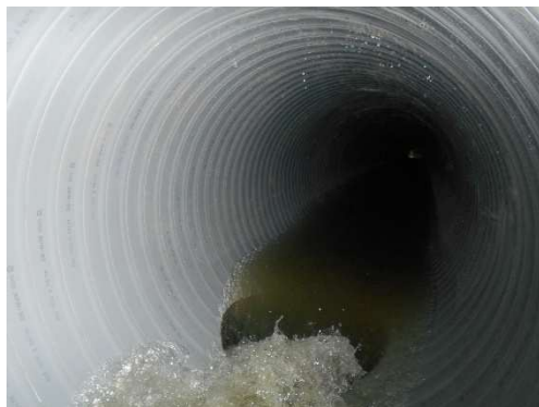
管渠更生後状況
