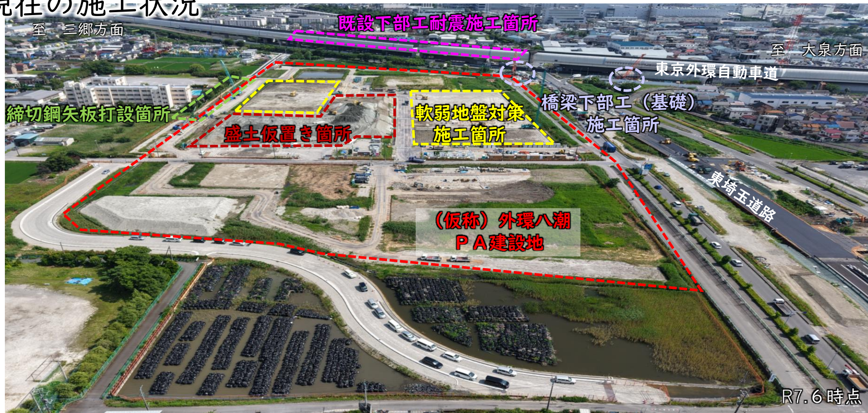
盛土仮置施工状況
