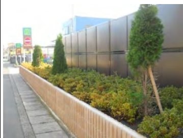
防音フェンス
