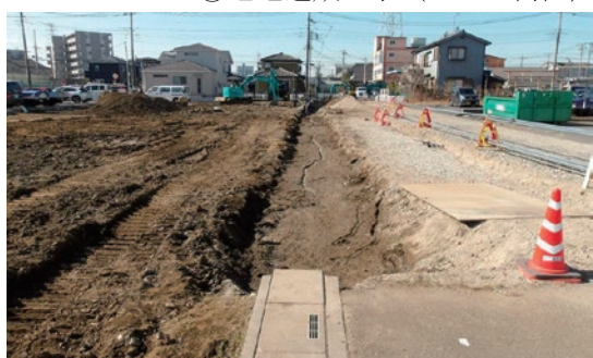
施工中（令和6年2月）
