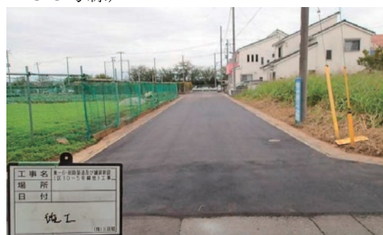
施工後（令和6年12月）
