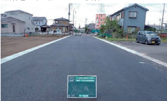
施工後（令和6年5月）
