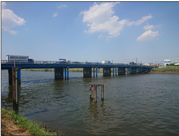
架け替えが予定されている八条橋
