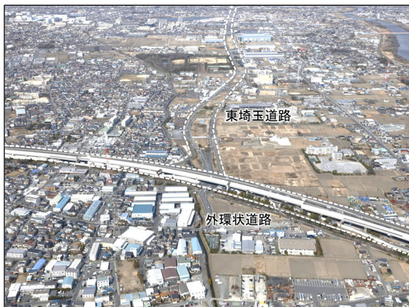
外環状道路及び東埼玉道路
