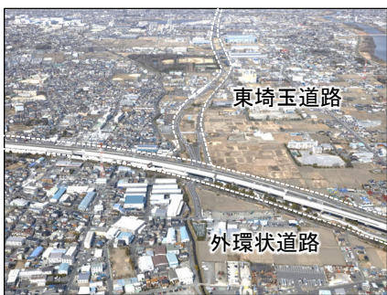
外環状道路及び東埼玉道路
