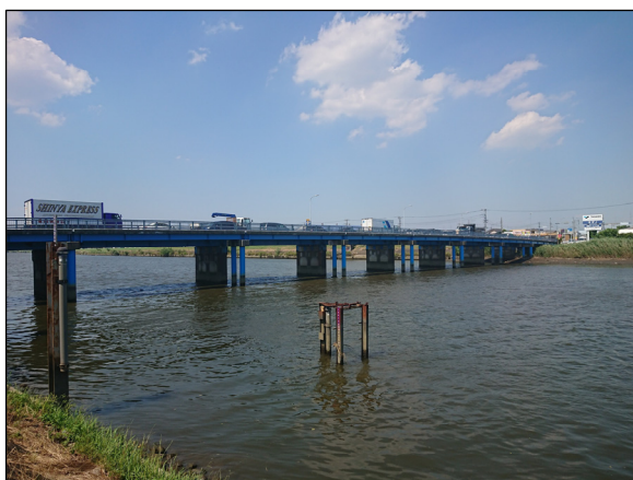
架け替えが予定されている八条橋
