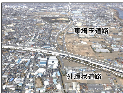
外環状道路及び東埼玉道路
