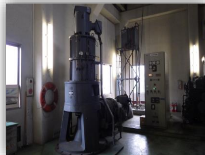
浮塚排水機場
