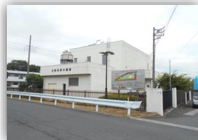
古新田ポンプ場
