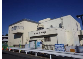
古新田ポンプ場
