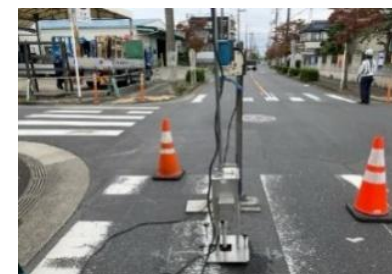
スコープカメラによる調査(2次調査)
