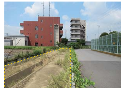
⑪ 水路の暗渠化による歩道の拡幅
