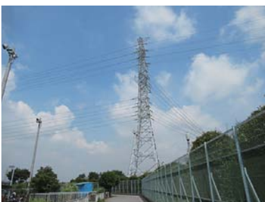
⑫ ヘリポート整備の条件確認
