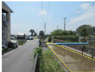
⑧ 水路の橋かけによる避難路の確保
