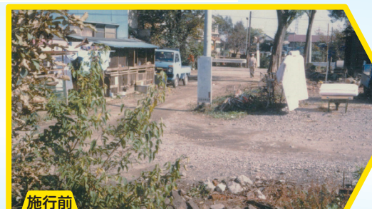
施行前 歩道、自転車専用通行帯、車道を分離させた道路となり、地域の安全性、利便性が高まりました。
