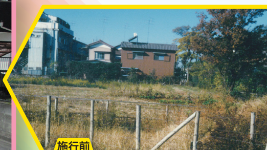
施行前 車道、歩道を分離させた9メートル幅員の道路を整備したことにより、地域の子供たちが安全に通学できるようになりました。
